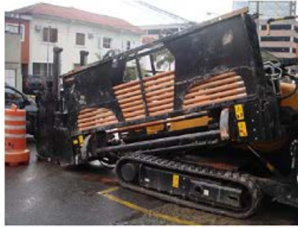
Figura 5: furo piloto, máquina perfuratriz com hastes metálicas e tubulação de PE. (Fonte: Sabesp/MCEA)
