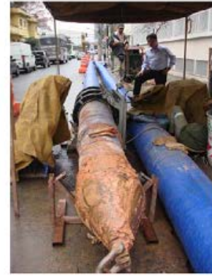
Figura 5: furo piloto, máquina perfuratriz com hastes metálicas e tubulação de PE. (Fonte: Sabesp/MCEA)
